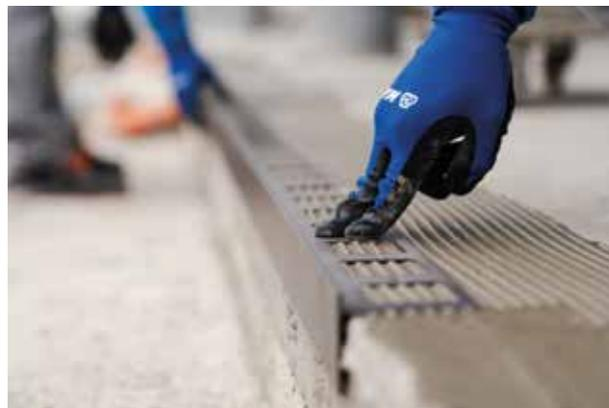
Al fine di preservare il sistema, la pavimentazione confinante con il terreno ha visto l'inserimento del profilo perimetrale della linea Protec CPNV di Profilpas.
