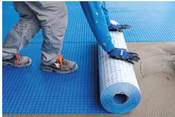
Per la pavimentazione esterna è stato realizzato lo strato impermeabilizzante con la membrana Mapeguard UM 35.
