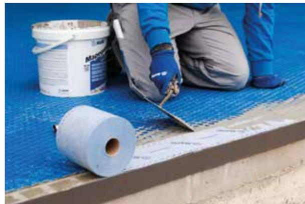
All'esterno, tra la membrana Mapeguard UM 35 e il profilo perimetrale di Profilpas è stato applicato il nastro Mapeband Easy con l'adesivo impermeabilizzante Mapeguard WP Adhesive.
