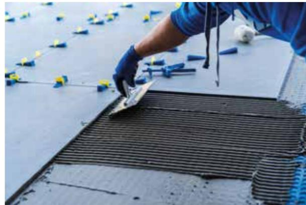
Per la posa delle piastrelle è stato impiegato l'adesivo Keraflex Maxi SI Zero\* e per mantenere omogenea la distanza tra piastrelle sono stati utilizzati i sistemi livellanti MapeLevel ProWDG.
